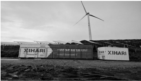
图4 高电压穿越试验现场 Fig. 4 High voltage ride- through test site
