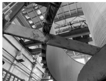
图6 铝吊架底部放电痕迹
